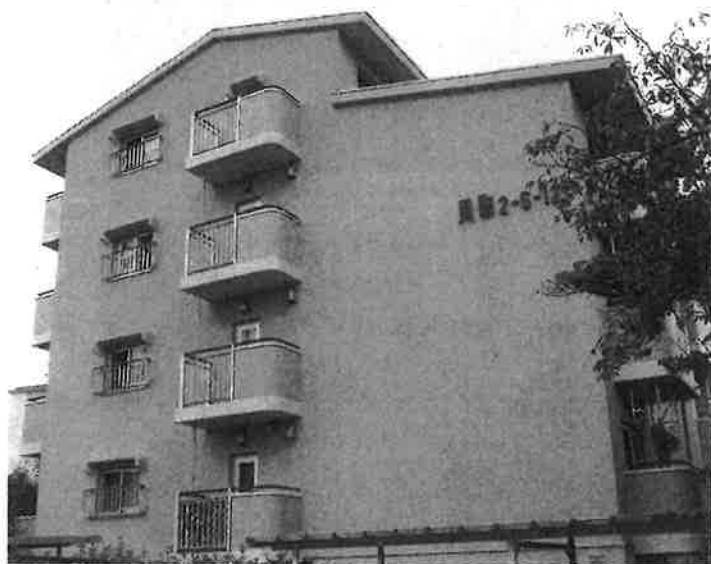
▲施工が完了した12号棟。
