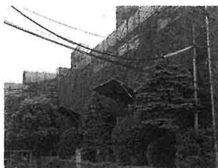
▲工事中の「エステート貝取-2」10号棟
