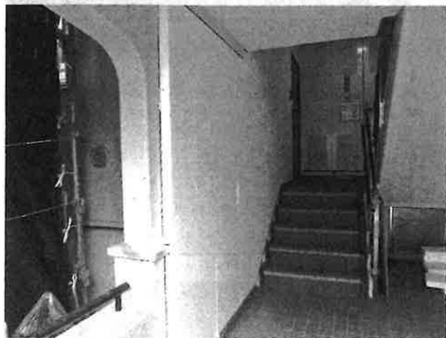
▲階段室への断熱材施工。EPS ボード 50mmをアクリル樹脂系接着剤で張付け。
